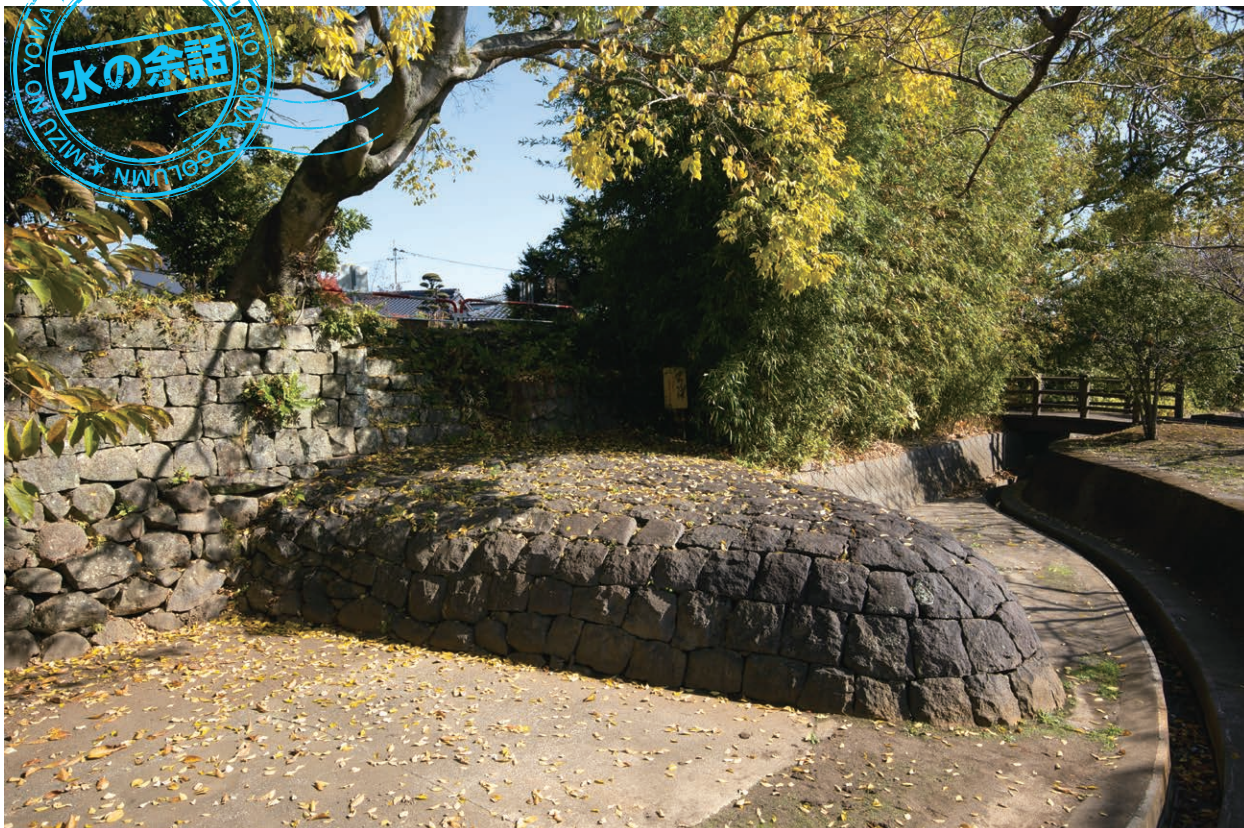
かつて白川で使われていた「石刳(いしはね)」。亀の甲羅のように石を積み上げ、水の勢いを弱めて川岸を守る。加藤清正が治水工事でよく用いた工法とされる
