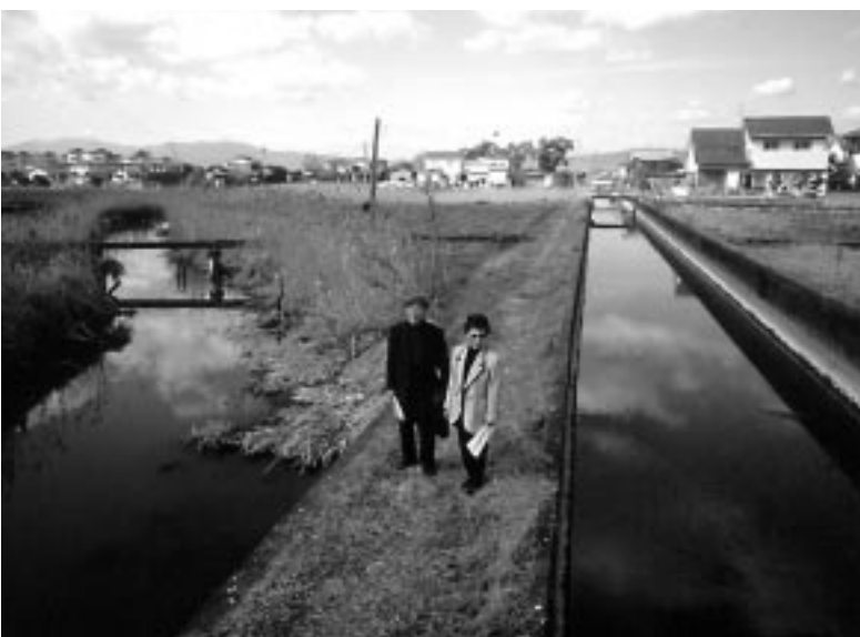
江湖堀とダムの用水幹線（佐賀市巨勢町付近） クレークは排水を兼ねるので、深く刻まれ低所を流れる。用水路は水源から遠い海岸地帯まで水を運ぶために高所を流れる。古代と現代の併存する佐賀平野 古代から現代に至る“水利構造物”の展示場である。
