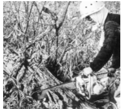
チェーンソーによる倒木処理 - 大型機械作業には伐根や大きな倒木が非常に障碍となる。昭和39年
