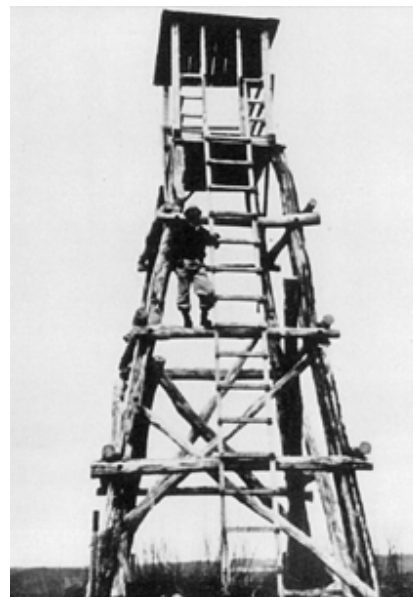
二代目望楼は木製で、針葉樹は皆無のため、別寒辺牛川沿いに生立していたヤチダモを伐採し、道もないので職員など、人の力で丸太を曳き上げ手作りで完成させた。昭和30年（ ）
