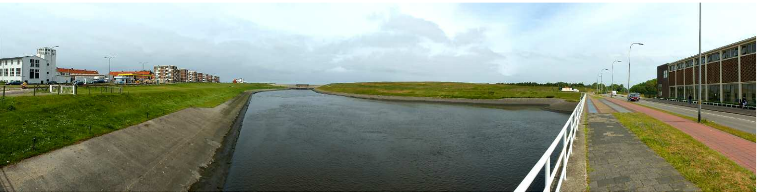
写真上：ラインラント水管理委員会の管轄するカットヴィークの排水機場（右建物）。ラインラントのポルダーの水は、ここから絶えず北海に向けて排水される。
