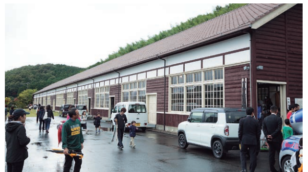
宇和米博物館の外観。耐震工事は完了したので、これからはZ・1グランプリは続けられる
