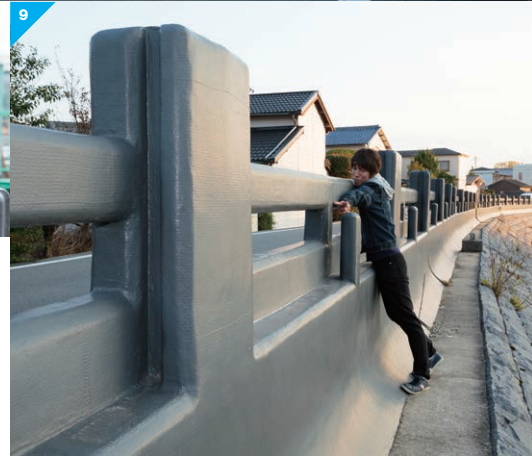
8 揖保川に沿って延々と続く畳堤。畳堤は、日本でも揖保川と長良川(岐阜県)、五ヶ瀬川(宮崎県)にしかない 9 畳堤の構造。畳(京間・本間サイズ)を1枚ずつ差し込んでいく。畳は水分を含むと膨らむので強度が増すという利点もある 10 畳堤について坂本さんに説明する国土交通省近畿地方整備局 姫路河川国道事務所の城谷吉彦さん(中)と庄司周夫さん(右) 11 支流・林田川へ水を送り込む取水口
