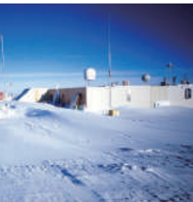
ドームふじ基地：主要部は雪面下にある（提供：国立極地研究所）
