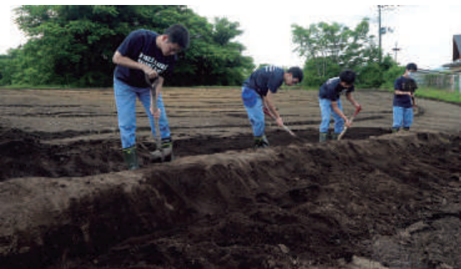
三和土を応用して土壌流出を抑えるための簡易堤防づくり
