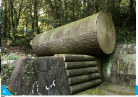
6 東大寺別院 周防阿弥陀寺にある関水のしくみを模したもの。水深の浅いところは水をせき止めて水位を上げ、その一部を開いて(丸太部分)大木を下流に流す水路にしたと考えられている
