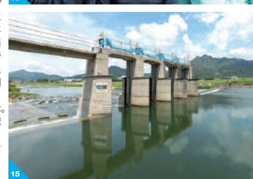
12 防府総合用水の「円筒分水工」。1951年から1958年の8年間で施工し、地域の水争いを解消した 13 「円筒分水工」を管理・運営している防府土地改良区の中川英明さん(左)、松井明美さん(中)、三谷勇生さん(右) 14 「円筒分水工」の水路は6本。耕作面積によって公平に水が配られている 15 「円筒分水工」の水はこの防府総合堰から引き入れている
