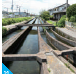
12 防府総合用水の「円筒分水工」。1951年から1958年の8年間で施工し、地域の水争いを解消した 13 「円筒分水工」を管理・運営している防府土地改良区の中川英明さん(左)、松井明美さん(中)、三谷勇生さん(右) 14 「円筒分水工」の水路は6本。耕作面積によって公平に水が配られている 15 「円筒分水工」の水はこの防府総合堰から引き入れている
