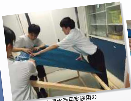
校内で行なった雨水活用実験用の小屋づくり
