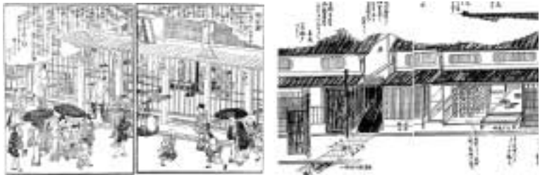
上：表店、棟割長屋、裏店から出た水は、町境下水を経て、川に注ぐ。 左上：石組下水と竹雨樋：中央の竹雨樋が屋根の雨水を下水に流している。（「風俗四季哥仙」"五月雨" 鈴木春信画） 下右：町境下水『守貞漫稿 卷之三』 下左：雨落下水 店の軒下に下水が描かれている。 錦袋園『江戸名所図会』
