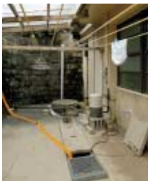
長く続く廊下を見ると、屋根の広さが実感できる。(上) オーバーフローしたときは、この排水溝から雨水を逃がす。(下)
