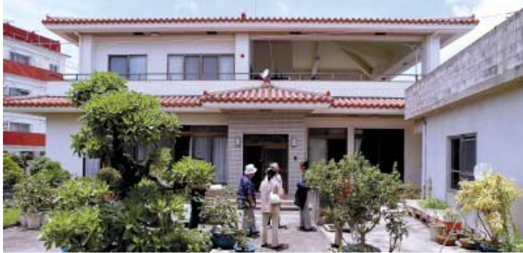
1938年からの雨水利用住宅 庭の下に48tの雨水タンクが埋められている。左から沖縄市観光協会顧問の仲宗根健昌さん、沖縄県雨水利用市民の会の上原辰夫さん、この家の主の神里興盛さん。 屋根からは貯水槽につながる管と、排水管の2本が設置され、オーバーフローしそうなときや台風で潮水が混じるときには切り替えられる。
