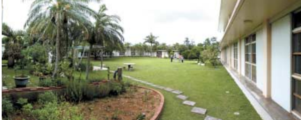
中庭(上)を囲む陸屋根すべてが集水面となっており、それが地下の貯水槽に入る。貯水槽の容量に対して、集水面が広すぎるとも思われる。壁の向こうは貯水槽。(左中央)中央に見えるメジャーは、浮きを利用した残量計で、水のかさは上下逆に表示される。貯水槽は8フィートの深さ。この空間は洗濯場として利用されている。
