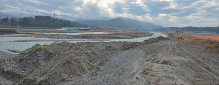
上：礫河原再生工事現場。天竜川の昔ながらの礫河原の風景を取り戻す試み。治水水面でも流れやすい河道になる
