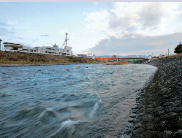
伊那付近の天竜川。平成 18 年水害時に大きな被害を受けた
