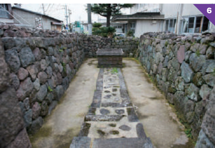
6 藩主・松平忠房が武家屋敷一帯の生活用水として設置した御用御清水。三の丸の用水として建設されたもの 7 湧水を南北の二方向に分けるために設けられた「量石」。南側(左)に流れる水は今も使われている
