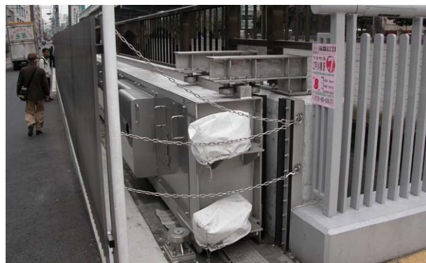
写真6 石切橋にある防水扉 資料提供：大松駿一さん
