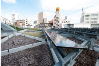
墨田区押上1-8-25 屋上開閉時間 9:00～20:00
