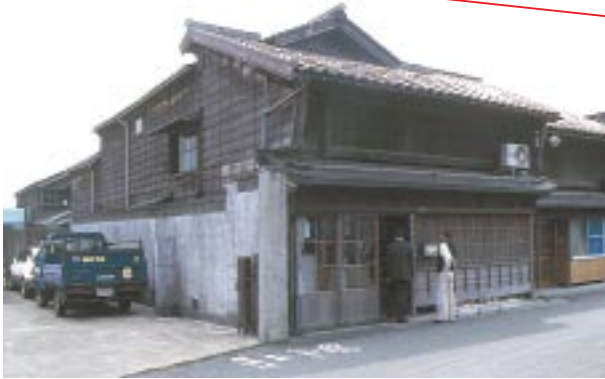
「カグラ建」の坂井家正面建物外観
