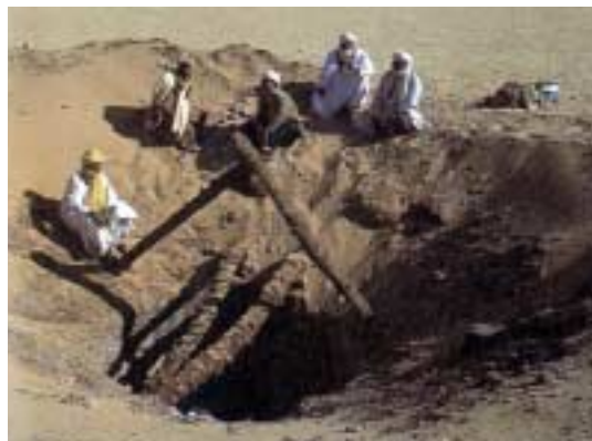
上：カナートの地下水道を補強するためのコンクリート製の輪。 中：アルジェリア・サハラ、チートオアシスのカナートの竪坑。3本立ての木材は原産のナツメヤシ。 右頁上：カナートの出口から水を汲み上げる、イランの村人。 右頁下：オマーン・プライミアオアシスにある村への導水路。車の向こうに点々と続くのが、ファラジ(カナート)の竪坑。 下：中国・トゥルファン盆地の古い坎児井(カンアルチン)(カナート)が崩れて現れた地層の断面。最低部には泥炭も見られ、古気候が想像できる。
