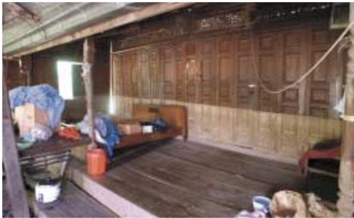
左上：アユタヤーの環状水路に面した高床式住居。他はその内部写真。 左：家が傾いているので、腰高に残る大洪水の痕が、奥に行くにしたがってはいよいよ高くなっているように見える。 上：正面扉についた水の痕が、左の写真より低く見えるのは、床の高さが違うからだ。
