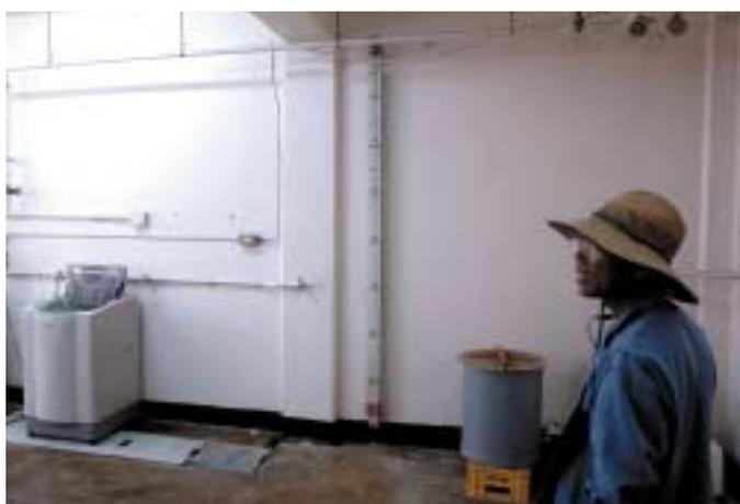
中庭(上)を囲む陸屋根すべてが集水面となっており、それが地下の貯水槽に入る。貯水槽の容量に対して、集水面が広すぎるとも思われる。壁の向こうは貯水槽。(左中央)中央に見えるメジャーは、浮きを利用した残量計で、水のかさは上下逆に表示される。貯水槽は8フィートの深さ。この空間は洗濯場として利用されている。
