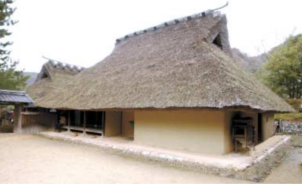
重要文化財指定を受けた民家は300軒前後あるが、建築年代が室町時代に遡るのは、ダム建設のため70m移築されたこの箱木千年家（兵庫県神戸市北区山田）と、古井家（兵庫県六粟郡安富）の2棟しかない。箱木家は室町時代の土蔵、近世の大庄屋にあたる。入母屋の軒がかなり低くまで延び、茅で葺かれた屋根が大きく見える。中に入って小屋組みを見上げると、室町時代の民家建築の木工技術の高さを伺い知ることができる。棟木や母屋を支える束柱に貫の補強が入り、かなり古いとされている部材の柱には、手斧のはつり痕が残る。
