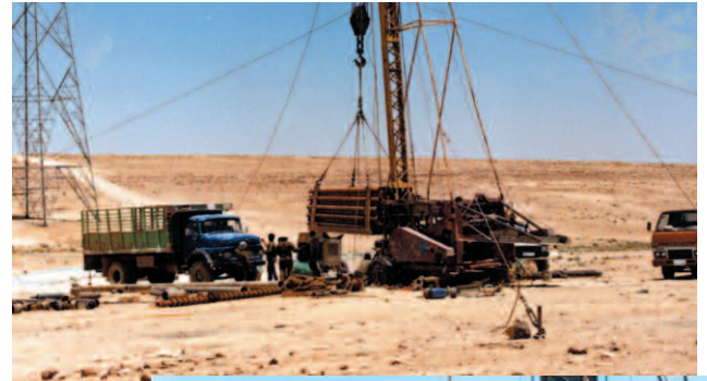
ヨルダンの井戸完成後の揚水試験 写真提供：村上雅博
