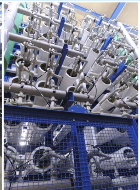
二ハールへ送る水を淡水化している Carboneras の施設と、CABO DE GATA 近くの海岸近くの国立公園内につくられた Rambla de Morales の淡水化施設を日を変えて見学したが、いずれも日本で見ると海水淡水化施設と基本的には変わらない。こちらでは、重油を使って自家発電した電気を利用。貴重な水をつくるとはいえ、膨大なエネルギーが費やされている。
