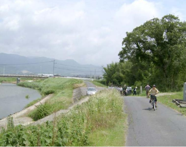
城原川（筑後川右支川）の野越 成富兵庫茂安（1560～1634）の造成。越流する所を限定し、越流堤を設けて破堤による氾濫を防ぐ。 大熊孝撮影
