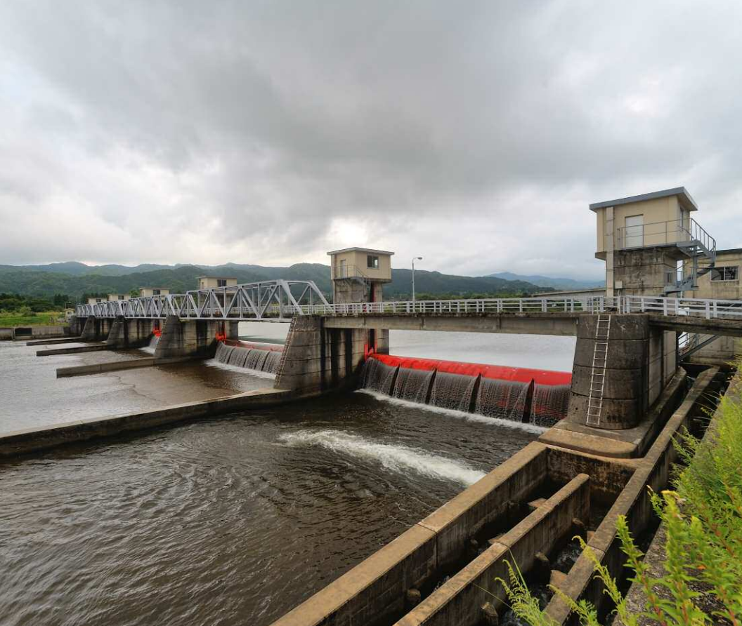
全可動型ゲートとして1968年度（昭和43）、鶴岡市に完成した赤川頭首工。
