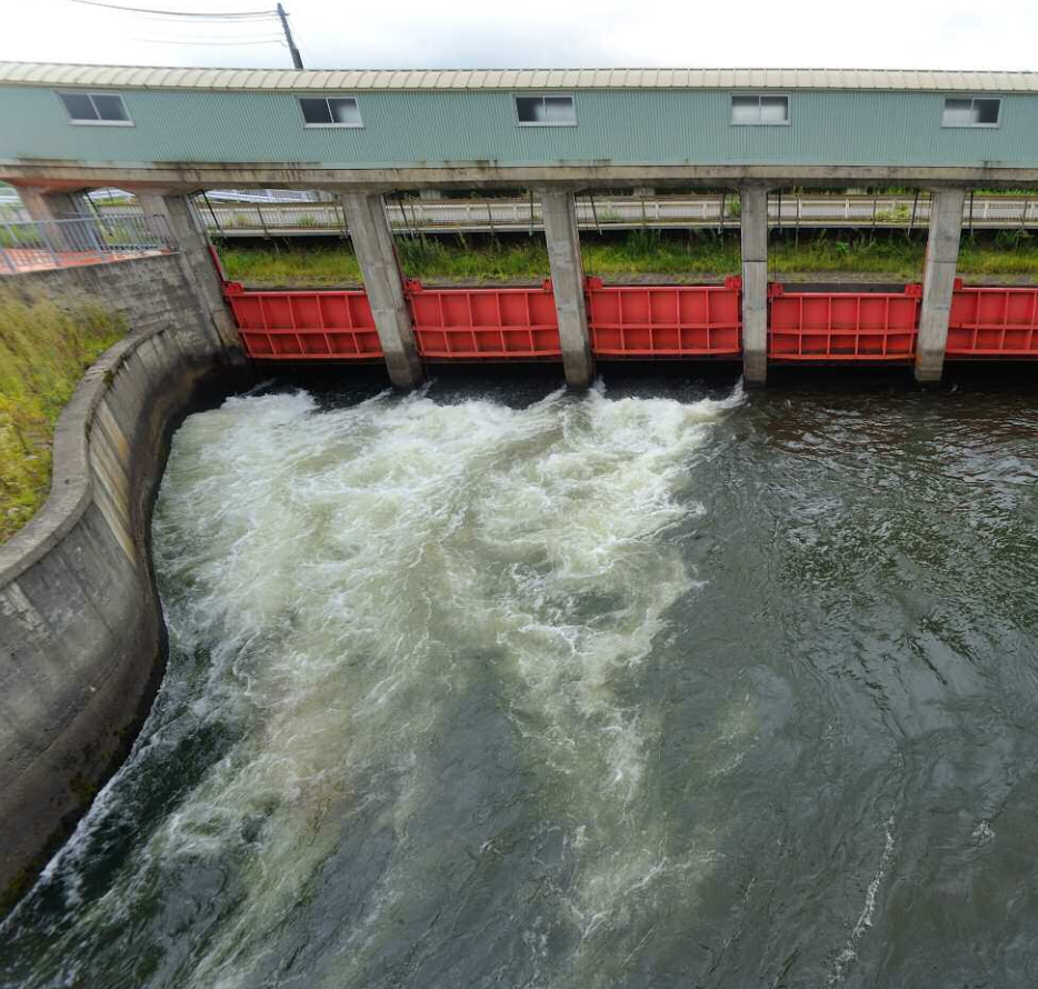
左：開水路サイフォン分水系における取水直後の開水路側の様子。
