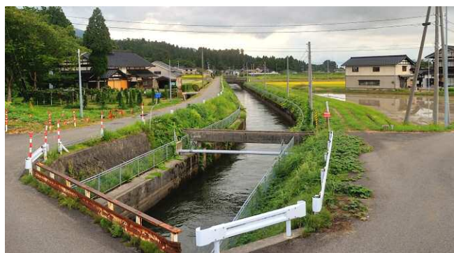
下：左の写真の水は、下の写真の水路で各受益地に運ばれていく。2系統に分けられたもう一方の流入水は、川の底をサイフォンでくぐって対岸に達する。
