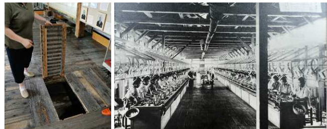
上：松ヶ岡開墾場の瓦葺き三階建ての大蚕室。10棟の内、5棟が現存する。屋根には1875年（明治8）に取り壊された鶴岡城の瓦が使われた。 下左：1階床の埋薪（まいしん）。床下の炉に生木を敷き詰めて上から灰汁をかけ、その上に炭火を置いて生木が徐々に燃えることによって長時間の暖房効果を得る仕組み。これにより、蚕期1サイクル中、燃料を補充しないで床暖房ができた。松ヶ岡では、稚蚕（1齢から3齢まで）期に埋薪を利用し、その後は自然の温度で蚕を飼育する清涼育を組み合わせて、飼育期間を短縮した。 下右：蚕糸業は新時代の花形産業として、大いに期待された。
