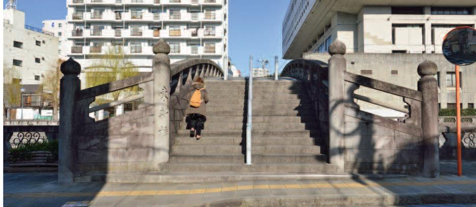
上：長崎大水害で流失後、1986年（昭和61）に架け替えられた東新橋。〈昭和の石橋〉として架けられたのは、これ以外に一覧橋、古町橋、編笠橋がある。勾配のきつい円弧のため、急な階段になっていて地元では評判が良くない。
