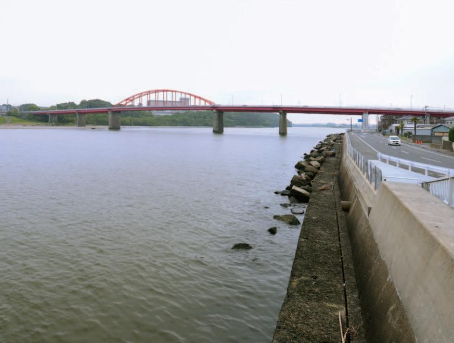
1998年8月の那珂川水害を受けてつくられた堤防から見た水府橋。手前は撤去中の初代・水府橋。老朽化および河川改修上の阻害箇所となっていたことから架け替えられ、2013年10月31日に二代目・水府橋が開通した
