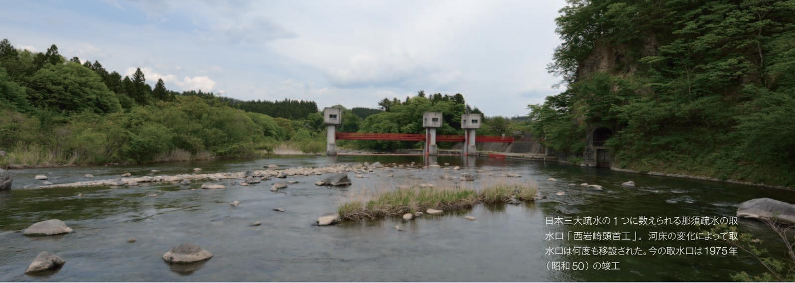
日本三大疏水の1つに数えられる那須疏水の取水口「西岩崎頭首工」。河床の変化によって取水口は何度も移設された。今の取水口は1975年（昭和50）の竣工
