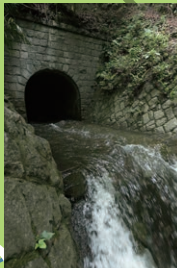
放水路トンネル
