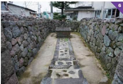
6 藩主・松平忠房が武家屋敷一帯の生活用水として設置した御用御清水。三の丸の用水として建設されたもの 7 湧水を南北の二方向に分けるために設けられた「量石」。南側(左)に流れる水は今も使われている
