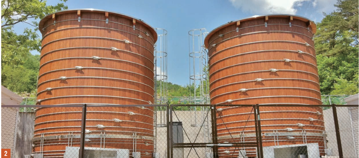
1 日本木槽木管株式会社で取締役と新城工場長を兼務する平川政治さん 2 宮城県産の杉を用いてつくられた仙台市泉岳自然ふれあい館の受水槽。直径4m×高さ4.8mの水槽2基。総容量は102㎡(提供:日本木槽木管株式会社)
