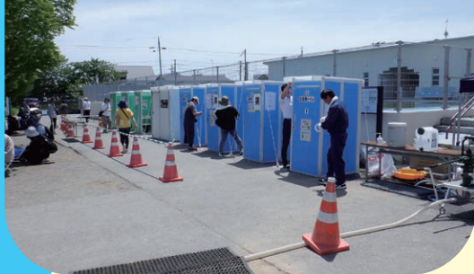
小学校の運動会でマンホールトイレを設置する行政職員と保護者。児童や保護者が実際にマンホールトイレを利用提供:東松島市建設部下水道課
