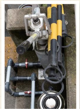
停電しても水が汲めるように手動ポンプを併設。真ん中のレバーで電動と手動が切り替えられる
