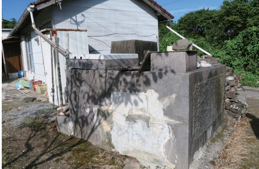
赤島の民家。屋根に降った雨水をパイプで集め、各戸に設置してある貯水槽に溜めて使っている 提供:福井工業大学笠井研究室
