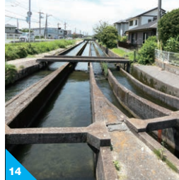
12 防府総合用水の「円筒分水工」。1951年から1958年の8年間で施工し、地域の水争いを解消した 13 「円筒分水工」を管理・運営している防府土地改良区の中川英明さん(左)、松井明美さん(中)、三谷勇生さん(右) 14 「円筒分水工」の水路は6本。耕作面積によって公平に水が配られている 15 「円筒分水工」の水はこの防府総合堰から引き入れている
