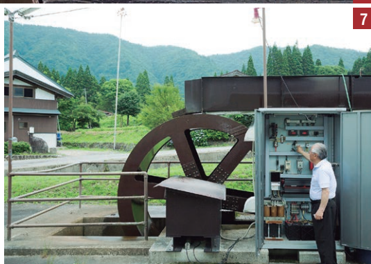
5 2009年に設置した「らせん型水車2号機」(最大出力800W)。発電した電気は住宅兼NPO事務所に供給している 6 水を受けて回転する「上掛け水車」 7 8 市販されている物置小屋を用いて久保田さんが自作した上掛け水車の制御装置
