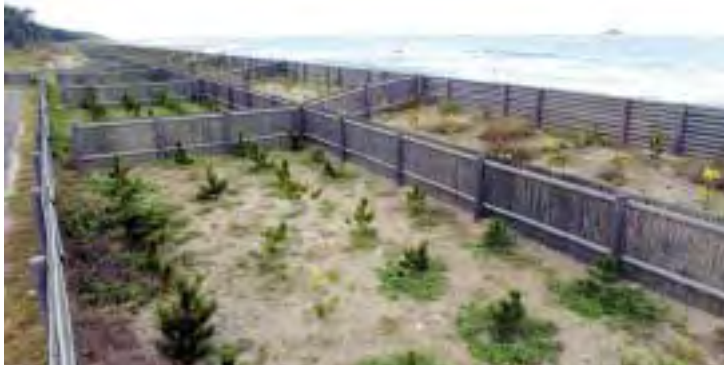
上：松を保護するために、碁盤の目のように作られた静砂垣。中に松の苗が植わっている。 下：スプリンクラーの導入で、砂丘の農業は飛躍的に可能性を与えられ、農家の過酷な労働は一気に軽減された。
