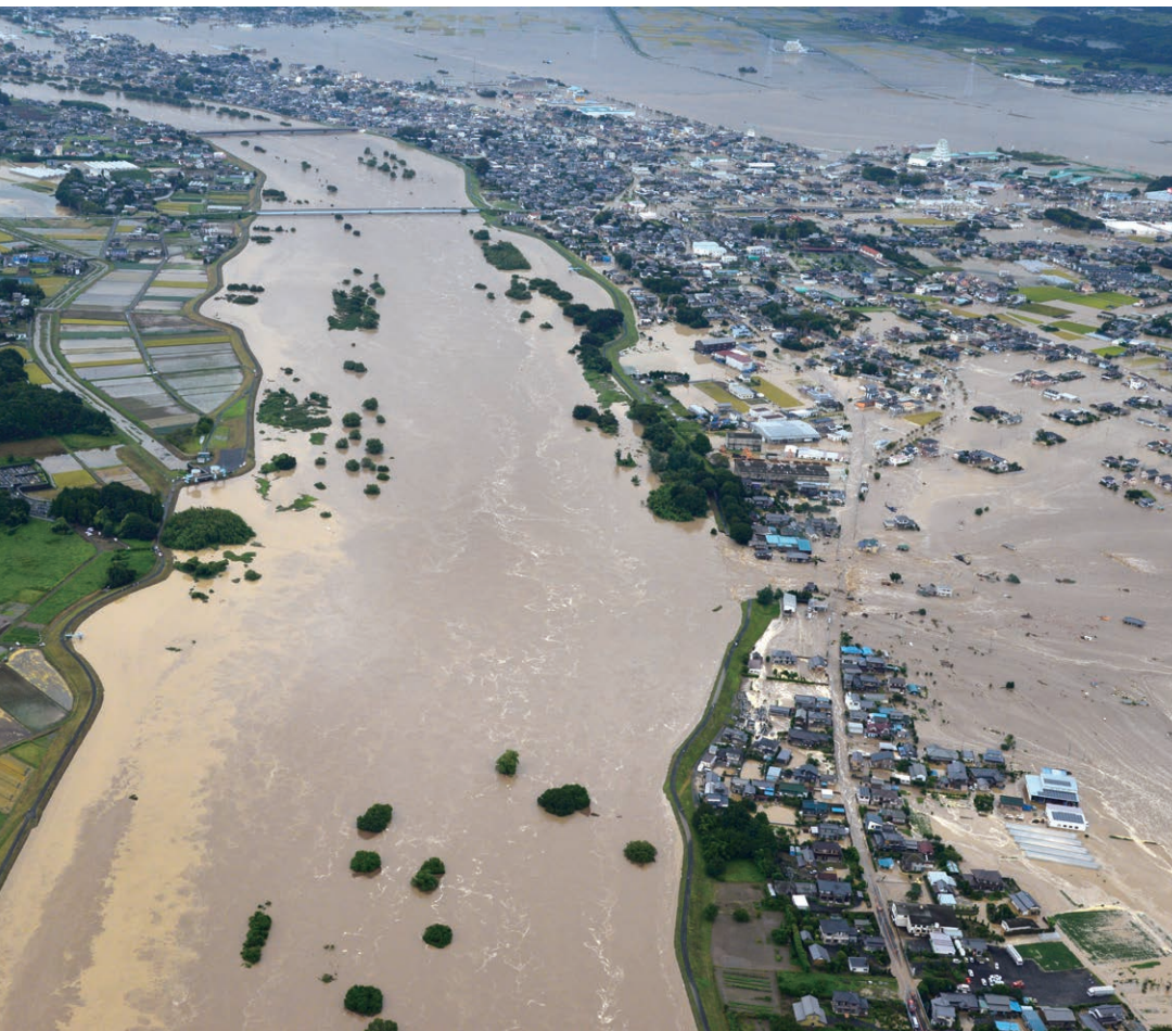
平成27年9月関東・東北豪雨で決壊した鬼怒川左岸21.0km付近からの氾濫の様子。溢水7カ所、漏水などの被害が発生した 提供:国土交通省関東地方整備局下館河川事務所
