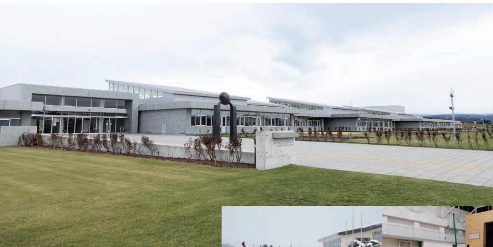
2014年に移転・新築した東川小学校の外観。先進的な授業が行なわれている
