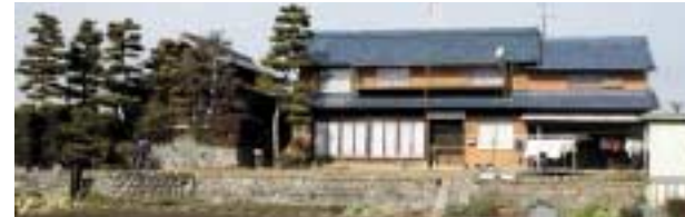
「輪中の郷」の近くにある、水屋を持つ農家。 上：正面左手、屋敷林で囲まれた建物が水屋。輪中の地面は砂地だったため、木が生えない。貴重な土を盛って作った水屋の土台の廻りに屋敷林を作ることは、薪の確保のために至極合理的なことであった。 左：母家側から見た水屋。水が引くまでの間の生活必需品を、水屋に備えるのはもちろんだが、一番大切なのは種籾であった。 下：裏手。
