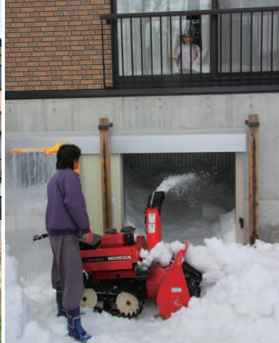
上段：基礎部を高くして雪室に利用している大羽賀邸。家庭用除雪機による初めての雪入れは、2010年（平成22）3月13日。約31tの雪が入れられた。下右：雪を入れる前の雪室内のダクト配管の様子。このダクトを通り、各部屋にクリーンな冷気が送られる。下左：利雪住宅の衆知と普及のために、大羽賀さんの家の前に掲げられていた看板。
