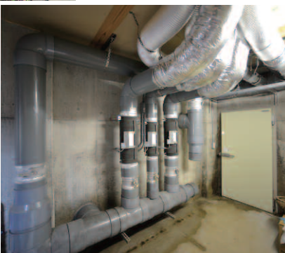
左：大羽賀邸。傾斜地に建つため、駐車スペースに利用できないことから、基礎部分の一部を雪室にした。下段右：倉庫として使われている空間と雪室との境には、標準設計の指示通りに業務用の冷蔵庫が使われている。下段中：調整室は優秀な冷蔵庫。下段左：室内の空気を雪室に送り込むダクト。
