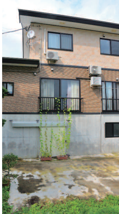
上段：基礎部を高くして雪室に利用している大羽賀邸。家庭用除雪機による初めての雪入れは、2010年（平成22）3月13日。約31tの雪が入れられた。下右：雪を入れる前の雪室内のダクト配管の様子。このダクトを通り、各部屋にクリーンな冷気が送られる。下左：利雪住宅の衆知と普及のために、大羽賀さんの家の前に掲げられていた看板。
