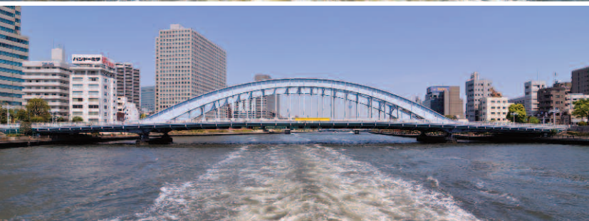
上から、22番の吾妻橋、23番の駒形橋、31番の清洲橋、33番の永代橋（番号は左ページの番記）。
