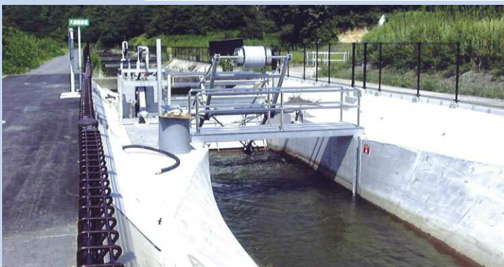
自動水位調節扉(上下流水位制御ゲート)
