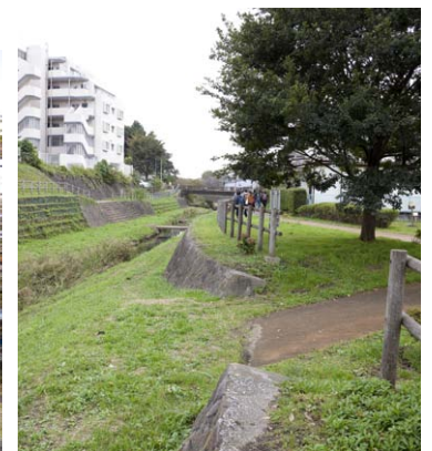
これは端部がうまく処理できていない例。へりが突き出したままなので地面との親和性が低いうえ、奥と手前の曲線の角度が異なるため連続性にも欠けている
