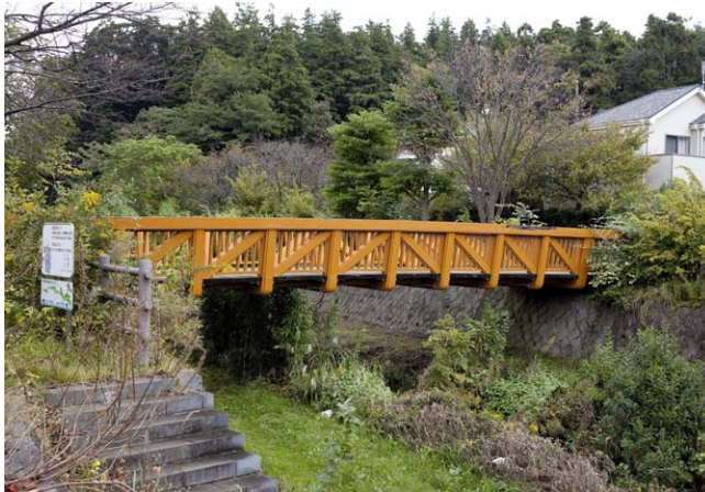
木造船の龍骨をイメージした木製のトラス橋「東山ふれあい橋」。橋脚がないためスマートに見える。「ただし、塗装の色が修繕時に変更されたことが残念」と橋本さん
