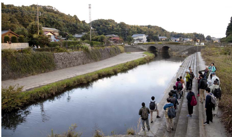
宮沢遊水地の上流部。参加者が立っているのが越流堤で、最上段が遊歩道。奥に眼鏡橋の山王橋が見える
