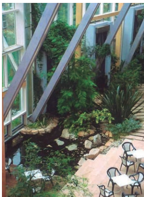
ドイツ・ニュルンベルク市のプリズマ。雨を屋根から集めて植栽テラスで浄化する(上)ほか、アトリウムには人工の滝からの冷たい空気が入る(下) (提供: Atelier Dreiseitl)
