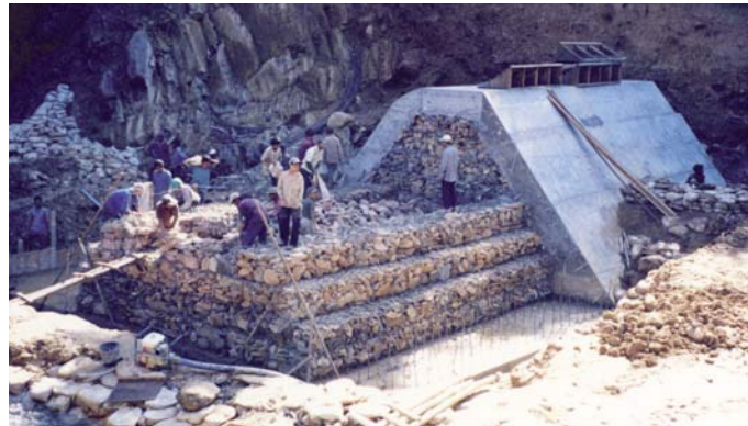
ラオス・ナムモン発電所 7村469戸を対象とした出力70kWの電化計画。流量0.55m 3 /s、落差18m。取水ダムは布団籠をコンクリートで補強した構造。発電用水車は日本製のポンプ逆転水車（ポンプを逆転させる構造） (事例写真は、すべて(財)新エネルギー財団より提供)
