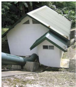
フィリピン・マハグナオ発電所 3村300戸を対象とした出力65kWの電化計画。流量0.45m 3 /s、落差25m。水圧管路に日本の技術基準で定められている管厚より薄い管を使用。発電用車はインドネシア製のクロスフロー水車。
