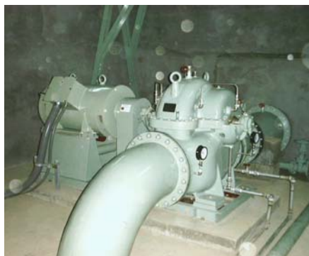
ラオス・ナムモン発電所 7村469戸を対象とした出力70kWの電化計画。流量0.55m 3 /s、落差18m。取水ダムは布団籠をコンクリートで補強した構造。発電用水車は日本製のポンプ逆転水車（ポンプを逆転させる構造） (事例写真は、すべて(財)新エネルギー財団より提供)
