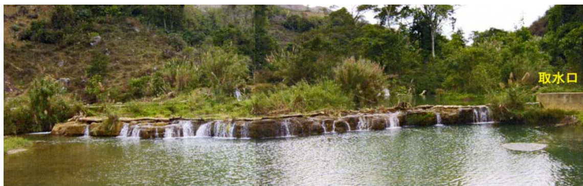
ベトナム・ナチャ発電所 5村552戸を対象とした出力120kWの電化計画。流量0.30m 3 /s、落差54m。水路は地元でも補修可能な石積み水路。発電用水車はイギリス製のターゴインパルス水車（ノズルから噴き出す水の力で水車を回す中・高落差用水車）。
