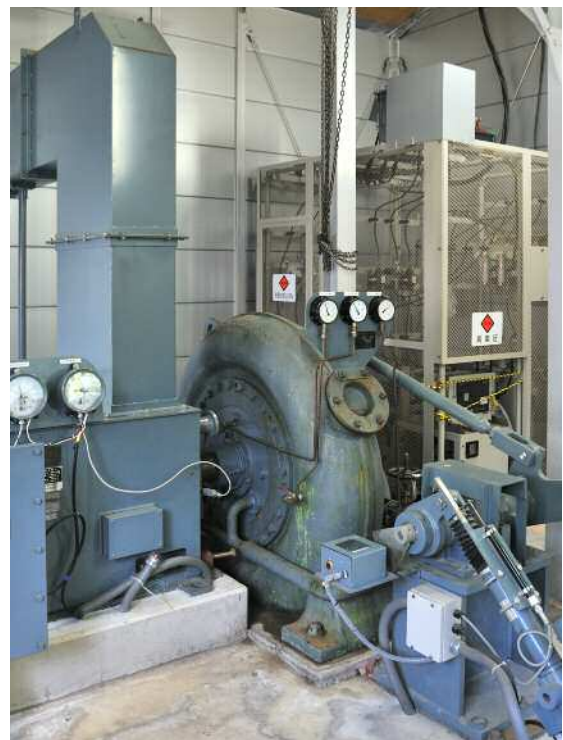
太田川の支流、水内川にある「水内川第一発電所」。発電開始は、1952年（昭和27）5月18日で、今はイームル工業が依託されて管理している。最大出力は170kW。上流部に専用の堰堤を設け、水路で水圧鉄管に導水して流下させている。水車のケーシング以外、すべてリニューアルしているようだ。
