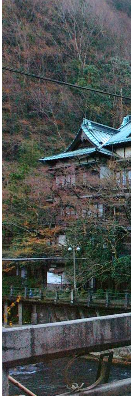
右：早川に面した、塔ノ沢の環翠楼。箱根越えの前に泊まるから、正面の顔は箱根湯本向き／環翠楼の名は、1890年（明治23）登楼した伊藤博文が命名した。額はなんと木象眼細工によるもので、揮毫は当代一の書家、長三洲（ちょうさんしゅう）。木象眼の作者は白川先石で、銘が確認できる数少ない作品の一つだ。 上：照明器具もすべて特注品。部屋の隅にドンと鎮座するのが、ファンコイルの装置。
