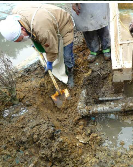
津波の被災直後のマリンピア松島。松島湾にあるたくさんの島が津波を抑えてくれたのだが、それでも泥や漂流物が流れ込み、売店のガラスが割れて商品などもすべて流されたという。配管類は泥に埋没したのを掘り起こし分解して熱湯で洗い、乾かしてから組み立て直した。電気に強い西條館長の指揮の下、普段から自分たちでメンテナンスを手がけてきた経験が役立つた。
