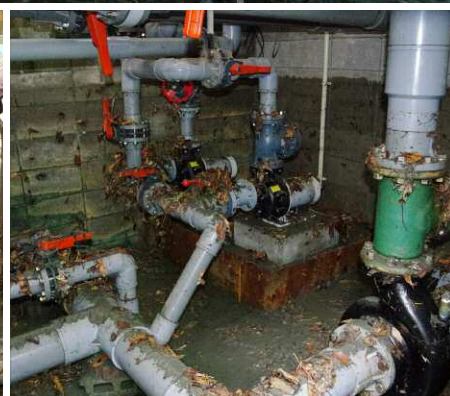
津波の被災直後のマリンピア松島。松島湾にあるたくさんの島が津波を抑えてくれたのだが、それでも泥や漂流物が流れ込み、売店のガラスが割れて商品などもすべて流されたという。配管類は泥に埋没したのを掘り起こし分解して熱湯で洗い、乾かしてから組み立て直した。電気に強い西條館長の指揮の下、普段から自分たちでメンテナンスを手がけてきた経験が役立つた。
