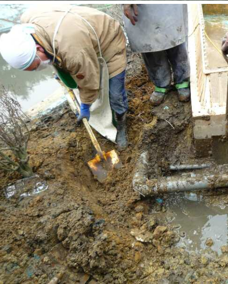
津波の被災直後のマリニピア松島。松島湾にあるたくさんの島が津波を抑えてくれたのだが、それでも泥や漂流物が流れ込み、売店のガラスが割れて商品などもすべて流されたという。配管類は泥に埋没したのを掘り起こし分解して熱湯で洗い、乾かしてから組み立て直した。電気に強い西條館長の指揮の下、普段から自分たちでメンテナンスを手がけてきた経験が役立つた。
