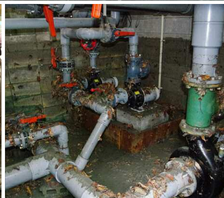
津波の被災直後のマリニピア松島。松島湾にあるたくさんの島が津波を抑えてくれたのだが、それでも泥や漂流物が流れ込み、売店のガラスが割れて商品などもすべて流されたという。配管類は泥に埋没したのを掘り起こし分解して熱湯で洗い、乾かしてから組み立て直した。電気に強い西條館長の指揮の下、普段から自分たちでメンテナンスを手がけてきた経験が役立つた。
