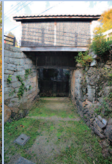
上：閘門の役目も兼ねた吉井水門。1762年（宝暦12）福岡・遠賀川につくられた〈中間唐戸〉のモデルになった/下：後楽園に置かれた、鑿（のみ）痕が見取れる岩。いったん割られた岩が、元の形のままに積み上げられている。
