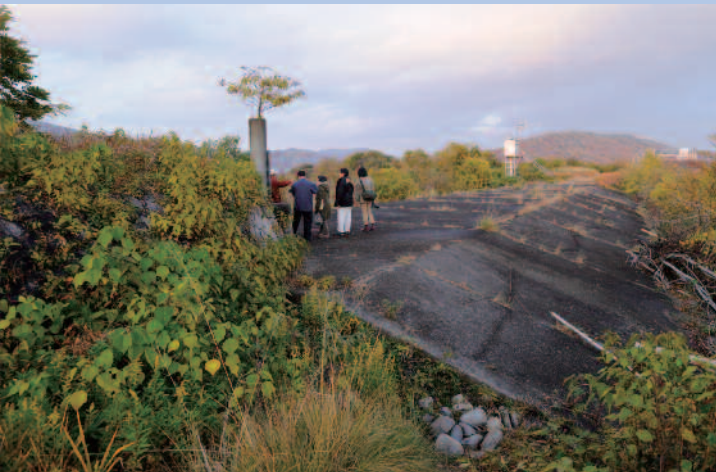
2段目と下2段：石積み部分が荒手の両端に見られる（亀の甲）。人が立っているコンクリート部分が越流堤だ／最下段：旭川左岸のエリアを潤している祇園用水を分水する祇園大樋。
