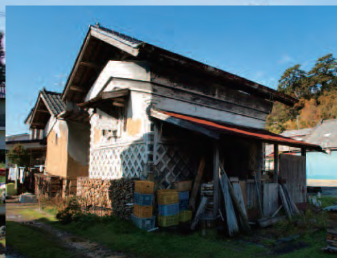
1897年（明治30）に建てられた双子の土蔵のかつての姿。西隣に建つ片割れは壊れてしまった。建築の前年には三陸沖大地震と津波があり、2万人以上の犠牲者を出したこの未曾有の天災から得た知恵が、この土蔵にも生かされていたはず、と本問さん。
