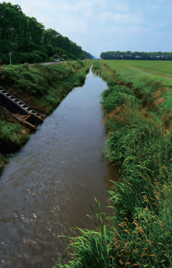
撮影したのは長沼ではなく名寄だが、地中に配管を巡らせる風景があちらこちらで見られた。北海道の低地の土壌改良工事は、現在進行形だ。
