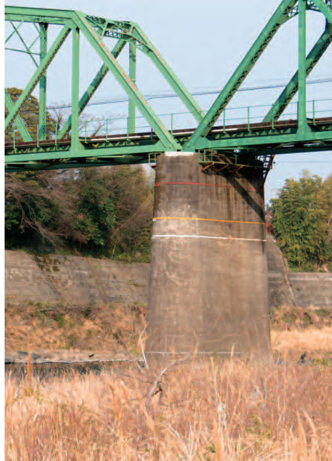
右：橋桁には、危険水位を表わす線が引かれていた。赤は警戒ラインだ。 上段：大分県日田市と熊本県阿蘇郡小国町にまたがる下笠（しもうけ）ダムは、日本最大級のダム 反対運動・蜂の巣城紛争の舞台でもあった／下段右：蜂の巣城紛争の中心人物であった室原知幸さ さんが書いた「下笠ダム反対」の文字から取ったといわれるダムの銘板／下段左：「公共事業は法に 叶い、理に叶い、情に叶わなければならない」は室原さんの言葉。
