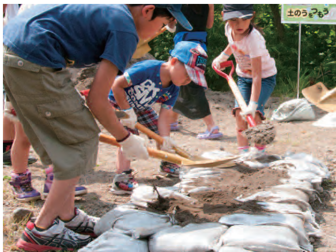
下段右：夕張川の橋桁についているのは、水位が上がったときの痕跡だ／下段左：子どもたちでも持てる小さい土嚢袋を使って、土嚢の積み方を習う。水の流れには袋のお尻を向けること、重ねたらよく踏み固めること、間に土を盛ることなど、たくさんのコツを習う。
