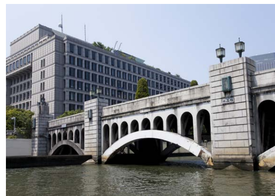
堂島川に架かる1929年（昭和4）竣工の「水晶橋」。こうした構造物を巡るのも楽しみの一つ
