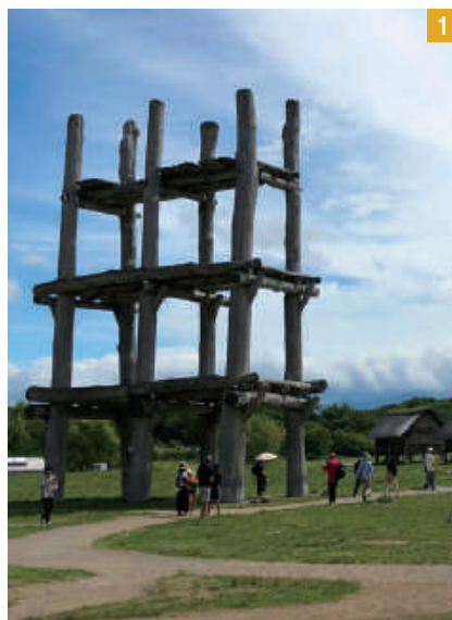
1 三内丸山遺跡に復元された大型掘立柱建物跡。クリの巨木が柱として使われていたという
