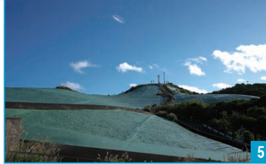
1 屋根に溜まった雨水を雨どいから貯水する三宅島の雨水貯留のしくみ。大きな石垣が貯水タンクとなっている。主に洗濯に使っているという 2 宮古島の東平安名崎(ひがしへんなざき)のそばにある洞窟の湧水。 3 洞窟の中から見た入り口 1 2 3 提供:須山聡さん 4 アメリカの環境保護NGOの「死ぬまでに見るべき世界の絶景13」に、日本で唯一選ばれている青ヶ島。丸で囲んだ部分は向沢取水場の集水面 5 青ヶ島の向沢取水場。山肌をコンクリートで固め、雨を貯水池に溜めることで水問題を解決した 4 5 提供:青ヶ島村役場
