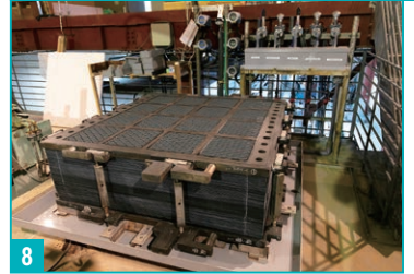
6 7 海水を淡水に替えて不純物をろ過する電気透析イオン交換膜法を用いた海水淡水化装置。水源の水を集めて屋外の急速ろ過設備で前処理を行ないこの装置を通す。メンテナンスは年に2回。6月と12月に7~8名が2週間かけて洗浄する 8 メンテナンス時や故障時に用いる予備の交換膜(1台)。膜2枚・網2枚の計4枚が1セットで、1台で260セット必要。それが全部で5台ある。膜は1枚5万円とかなり高価 9 海水淡水化施設を備えた古里浄水場。屋外にあるのは急速ろ過設備で奥の建屋に海水淡水化装置がある 10 右から与論町水道課の富永淳さん、仁禮和男さん、浄水場や水源地の管理を担う平田裕之さん
